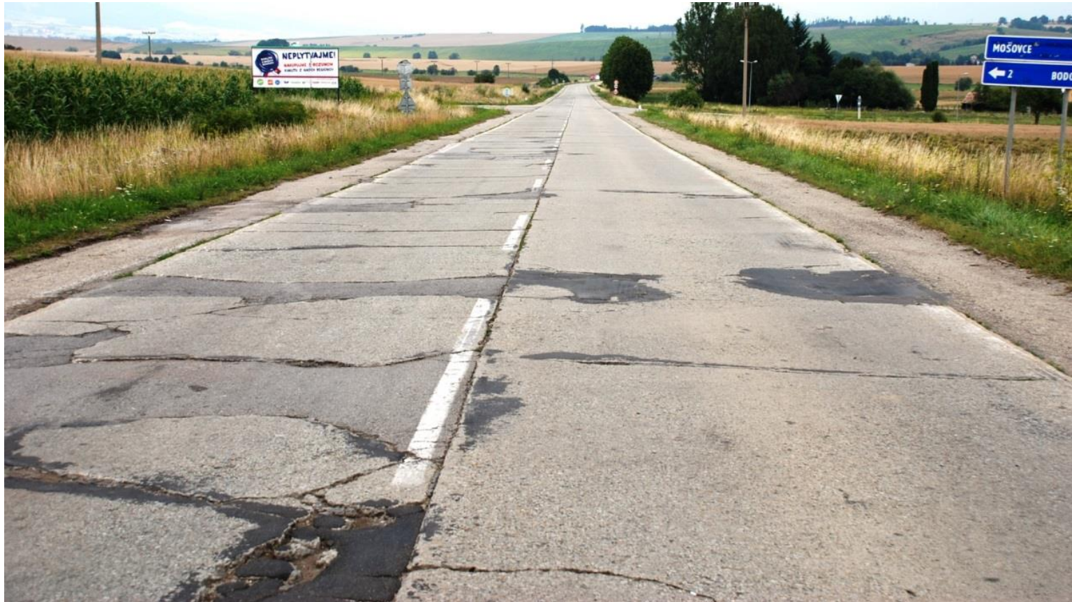
Stav degradácie cementobetónovej vozovky I/65 Turčianske Teplice – Pribovce po 40. rokoch exploatacie
