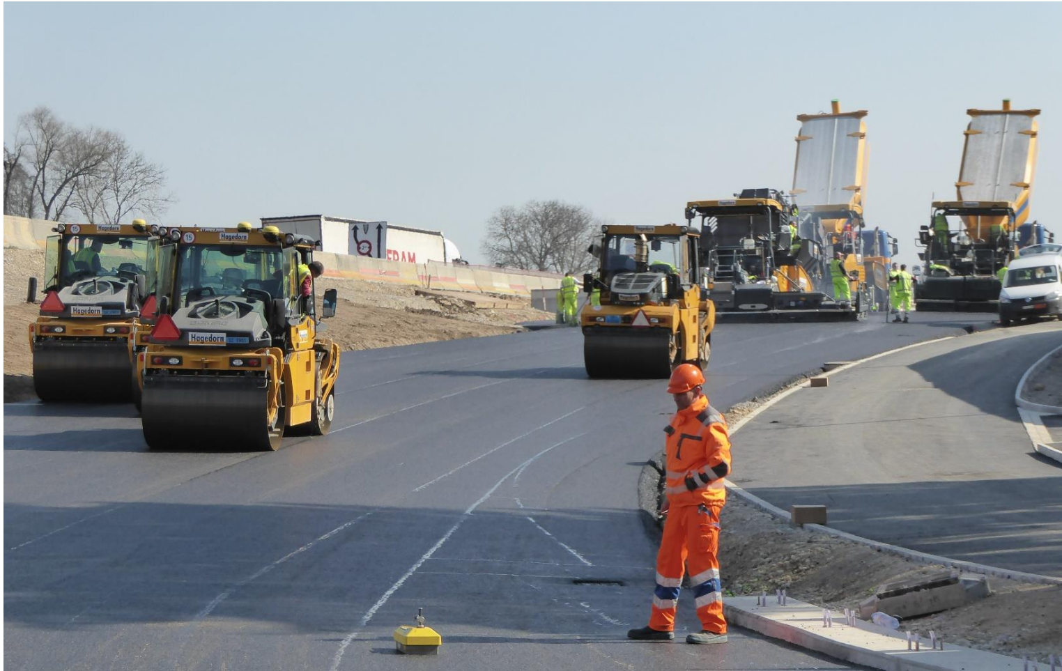
Pokládka asfaltové směsi VMT ve Švýcarsku
