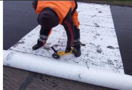
Bild 1-2: Ist-Zustand zeigt Schadensbild Einzelrisse quer zur Fahrbahn. FB Unebenheiten mittels fräsen entfernt. Bewehrtes Asphaltvlies nach Emulsionsauftrag mittig über Einzelrisse abrollen in das Bitumen drücken und mit Akkuflex schneiden. Perfekte faltenfreie Verklebung (Haftzug) von Provies.
