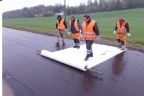
Bild 1-2: Ist-Zustand zeigt Schadensbild Einzelrisse quer zur Fahrbahn. FB Unebenheiten mittels fräsen entfernt. Bewehrtes Asphaltvlies nach Emulsionsauftrag mittig über Einzelrisse abrollen in das Bitumen drücken und mit Akkuflex schneiden. Perfekte faltenfreie Verklebung (Haftzug) von Provies.
