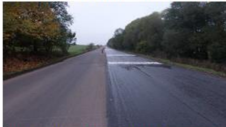
Bild 1-2: Ist-Zustand zeigt Schadensbild Einzelrisse quer zur Fahrbahn. FB Unebenheiten mittels fräsen entfernt. Bewehrtes Asphaltvlies nach Emulsionsauftrag mittig über Einzelrisse abrollen in das Bitumen drücken und mit Akkuflex schneiden. Perfekte faltenfreie Verklebung (Haftzug) von Provies.
