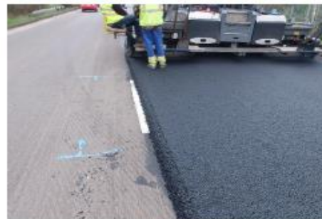
Bild 5-6: Halbseitiger Asphalteinbau über streifenweise verlegtes Provies RVS Asphalt RC60, Asphaltbewehrung liegt dort wo der größte Effekt erzielt wird = wirtschaftlicher Einsatz von Baumaterial. Stoß von Asphaltbewehrung und Asphaltnaht versetzen.
