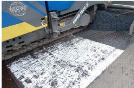
Bild 5-6: Halbseitiger Asphalteinbau über streifenweise verlegtes Provies RVS Asphalt RC60, Asphaltbewehrung liegt dort wo der größte Effekt erzielt wird = wirtschaftlicher Einsatz von Baumaterial. Stoß von Asphaltbewehrung und Asphaltnaht versetzen.
