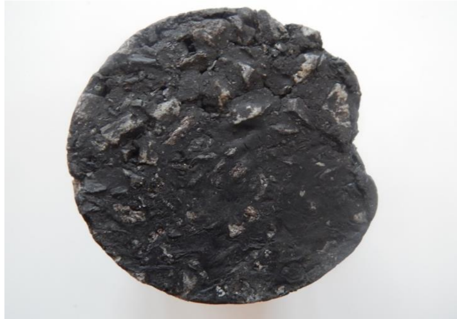
Jádrový vývrt – vypocené asfaltové pojivo
