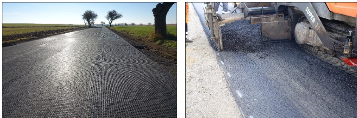
Obrázek 1: Vlevo – pohled na instalovanou samolepicí geomříž na povrch vozovky, vpravo – detail pokládky asfaltové vrstvy na geomříž
