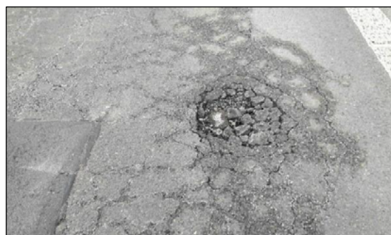
Obrázek 4: Pokles a rozpad obrusné vrstvy
