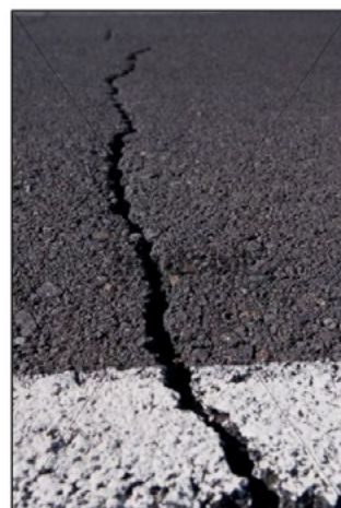
Obrázek 3: Trhlina
