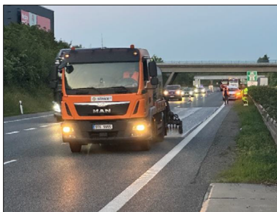
Obrázek 7: Aplikace regeneračního postřiku
