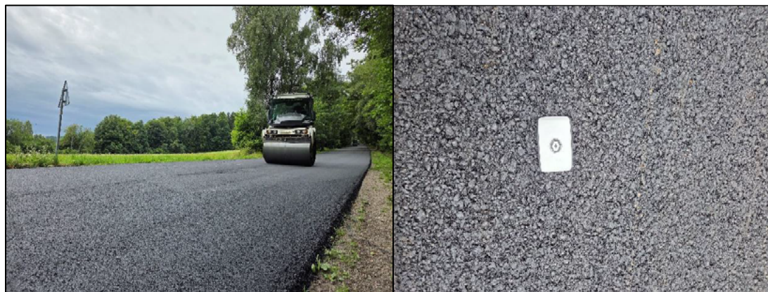
Obrázek 7: Hutnění asfaltové vrstvy ACO 11+ včetně detailu na zhutněnou asfaltovou směs
