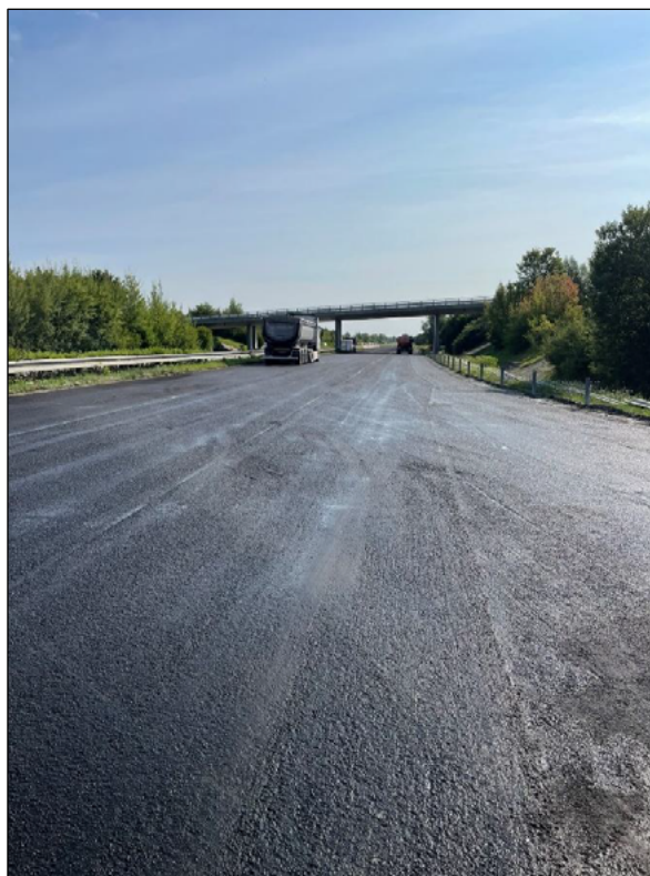
Obrázek 9: EMK a SAMI vrstva před pokládkou ACL
