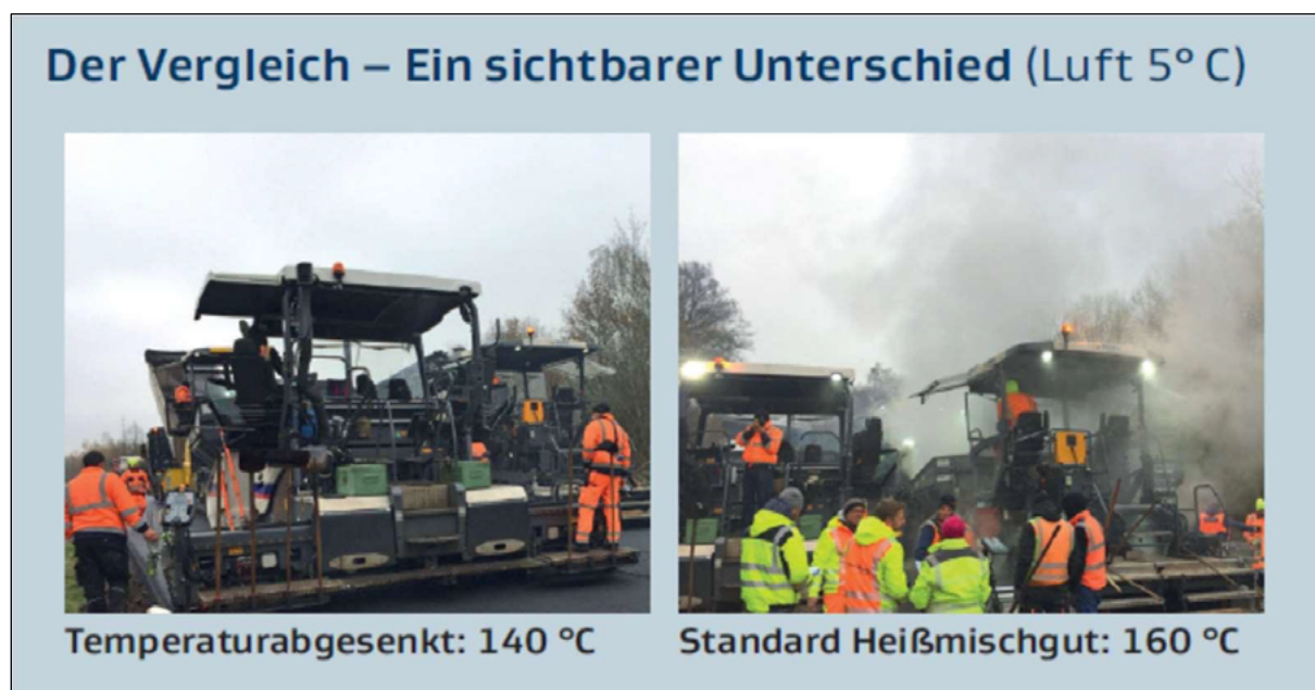
Obrázek 5: Porovnání pokládky standardní asfaltové směsi s teplotou 160 °C a nízkoteplotní asfaltové směsi s teplotou 140 °C (teplota vzduchu 5 °C)
