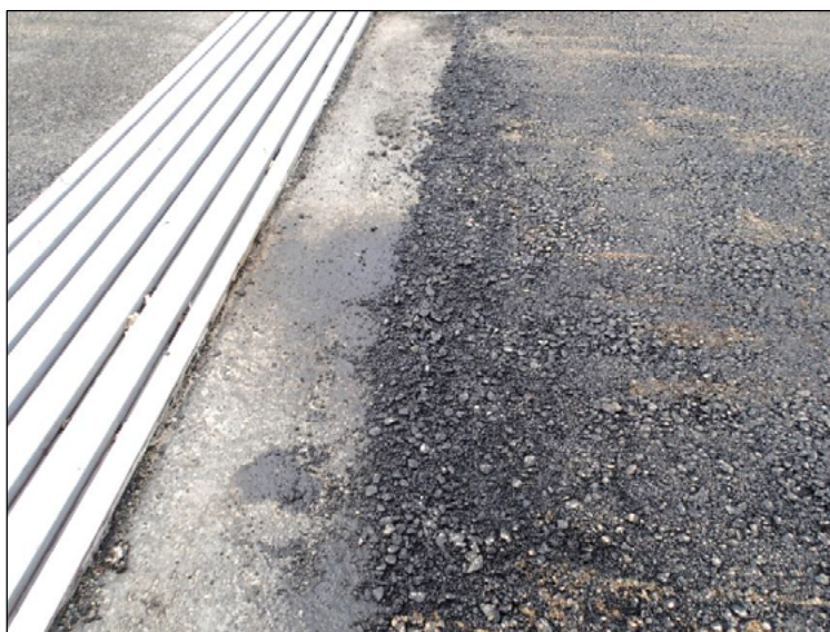
Obrázek 10: Segregovaná a rozděšená směs při ukončení na šikmé ploše
