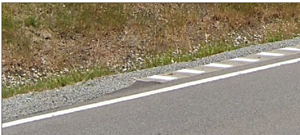
Obrázek 4: Zpevnění krajnice betonovými tvarovkami s nerovným povrchem
