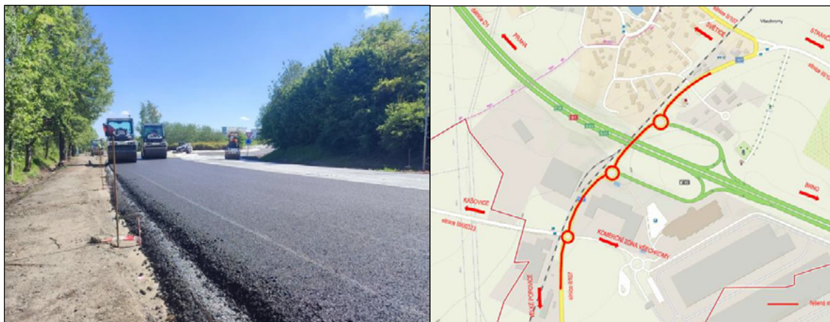
Obrázek 6: Umístění stavby a pohled na hutnicí sestavu v akci
