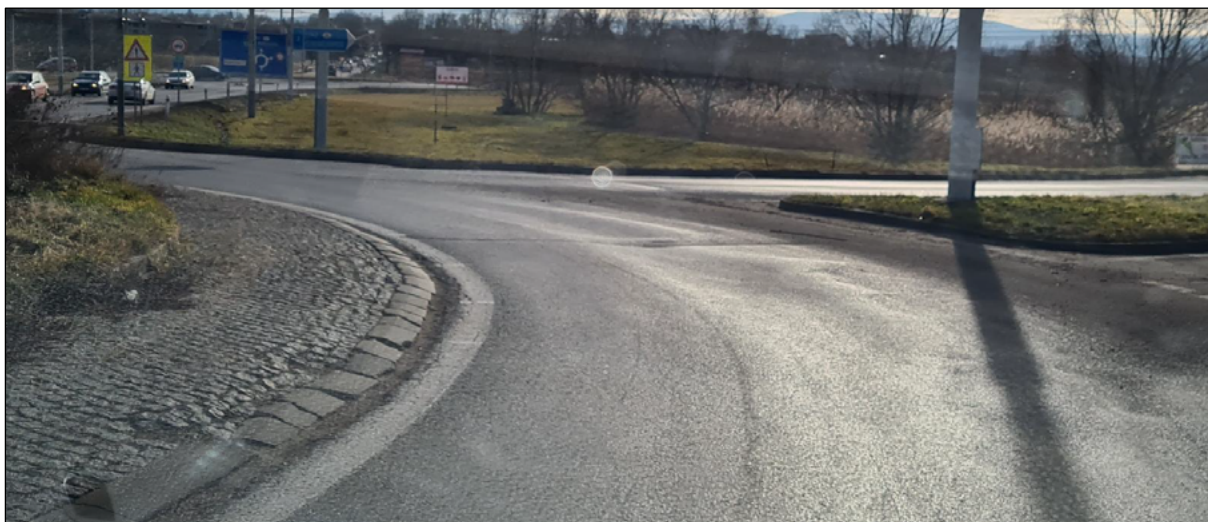
Obrázek 5: Poruchy prstence, obrub a vozovky jízdního pásu
