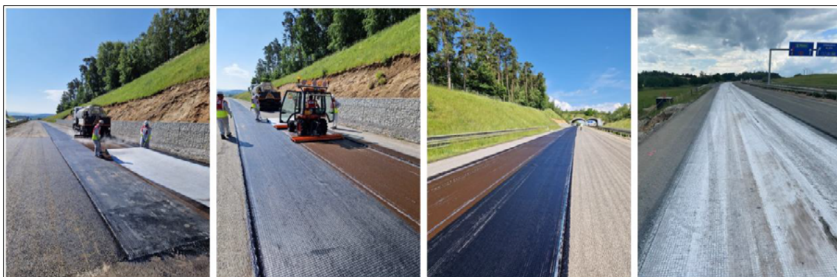
Obrázek 3: Realizace na stavbě dálničního typu
