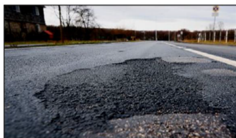
Obrázek 2: Ztráta hmoty
