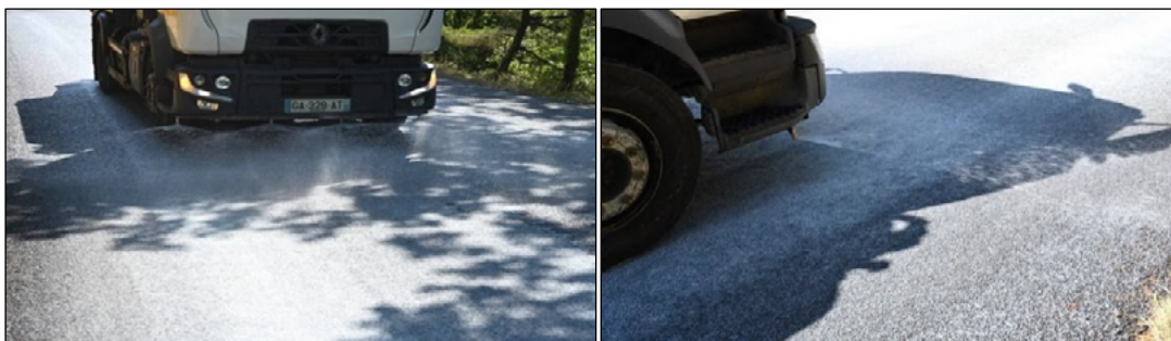
Obrázek 14: Provádění postřiku Adhefend™ C45
