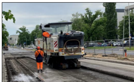
Obrázek 1: Frézování asfaltové vozovky – selektivní frézování jednotlivých vrstev [zdroj: P. Ostrowski]
