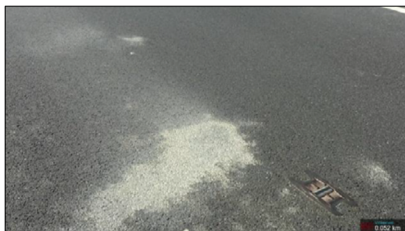
Obrázek 3: Nánosy šedého povlaku
