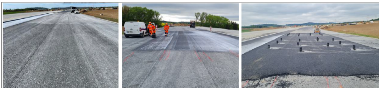
Obrázek 2: Industriální aplikace, zkušební úsek pro zkoušky geokompozitů
