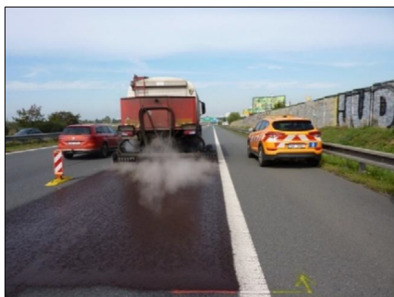
Obrázek 7: Aplikace regeneračního postřiku
